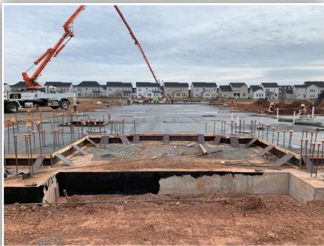
SLAB ON GRADE POUR
